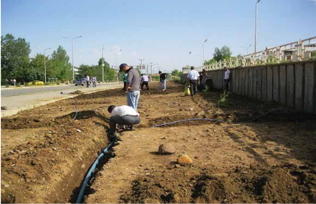
Resim: Öğretmenevi Altı Refüjünde Yapılan Toprak Düzenleme ve Sulama Tesisatı Döşemesi ve Çim Ekimi Çalışması
