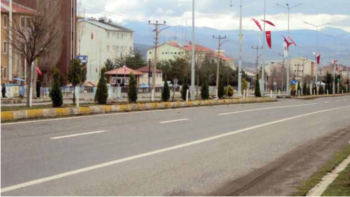
Resim: Muş-Elazığ Yolu Orta Refüje Büyük Boylu Piramit Mazı Fidanı Dikimi Yapıldıktan Sonra Refüjde Görünüm.
