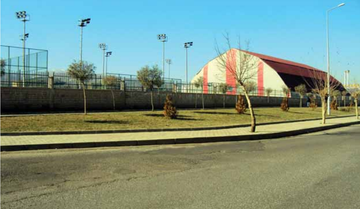
Resim: Uydukent Mah. Palamut Cad. Toprak Düzenlemesi Ve Çimlendirme Yapıldıktan Sonraki Hali
