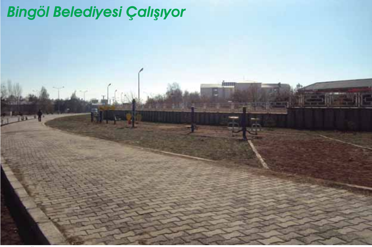
Resim: Öğretmenevi Altı Refüjünde Yapılan Toprak Düzenleme Çalışması ve Çimlendirme Sonrası Hali
