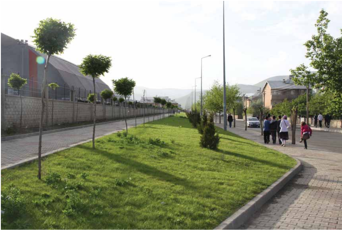
Resim: Uydukent Mah. Palamut Cad. Toprak düzenlemesi ve çimlendirme yapıldıktan sonraki Hali
