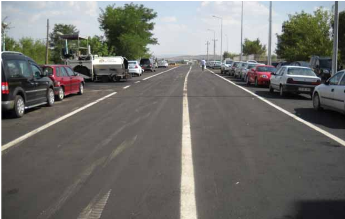
Küçük Sanayi Sitesi'nde Asfalt Çalışması Yapıldı
