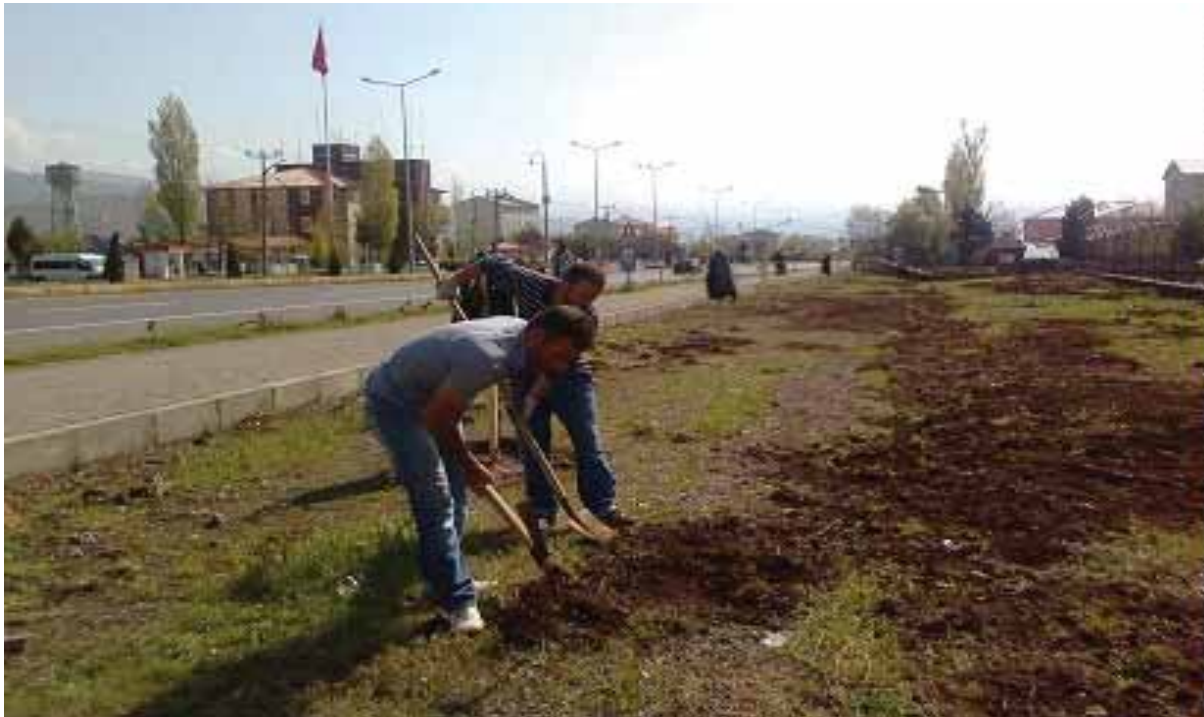
Resim: Polis Lojmanları Mevkiinde Toprak Düzenleme Ve Fidan Dikim Çalışması
