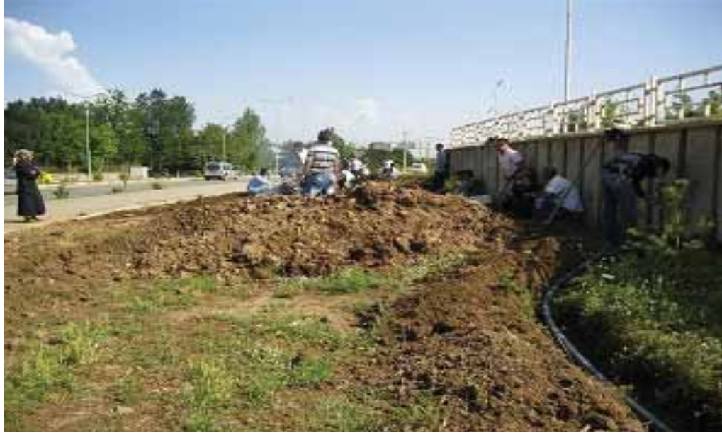
Resim: Öğretmenevi Altı Refüjünde Yapılan Toprak Düzenleme ve Sulama Tesisatı Döşemesi Çalışması
