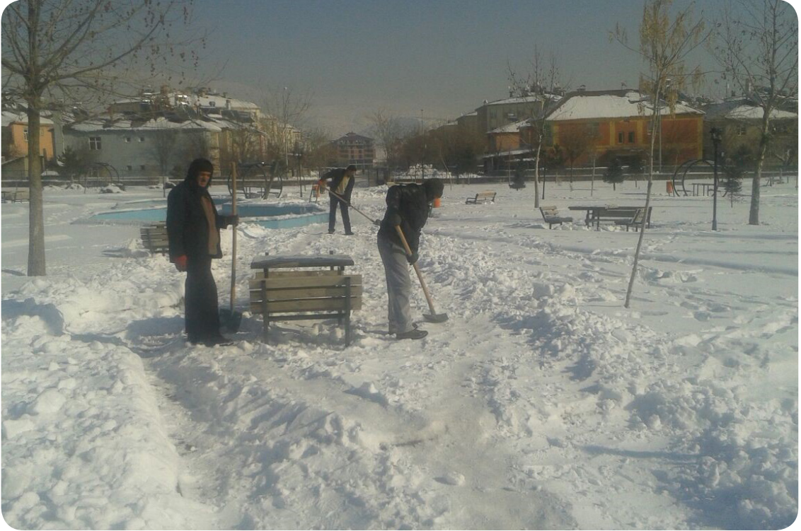
Kar temizleme çalışması yapıldı.
