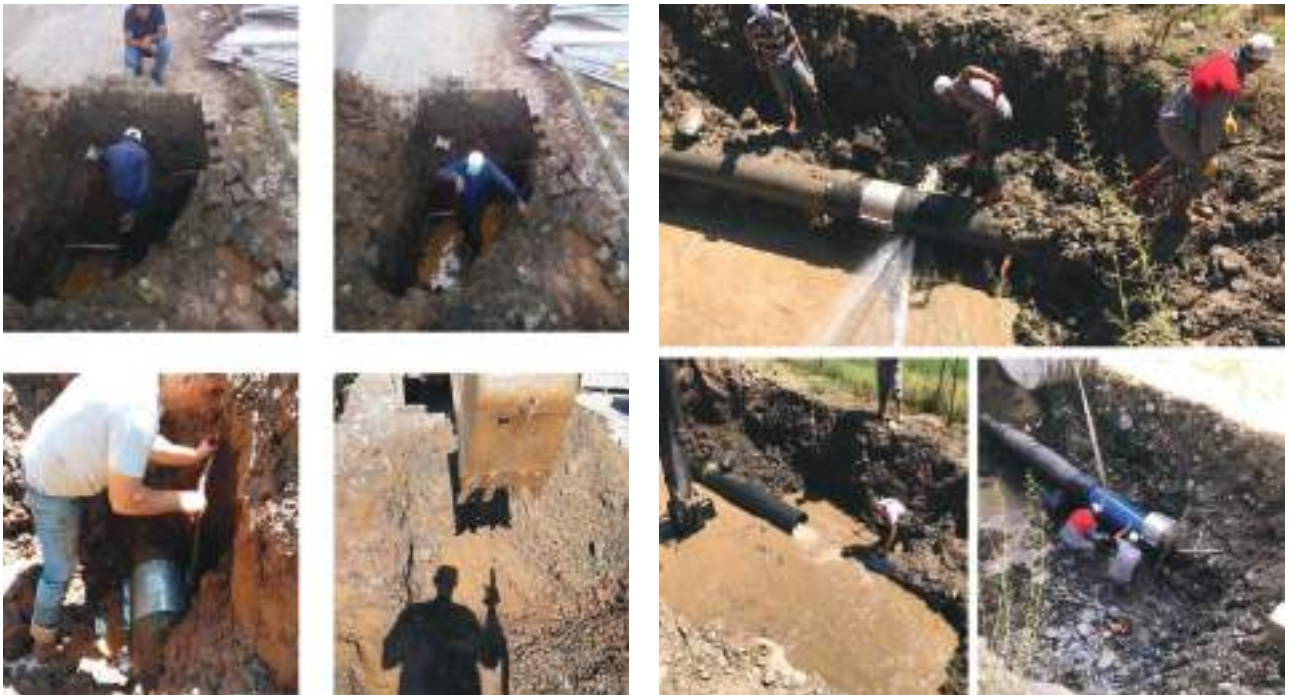
Muhtelif Cadde ve Sokaklarda Meydana Gelen İçmesuyu Arızaları Onarımı
