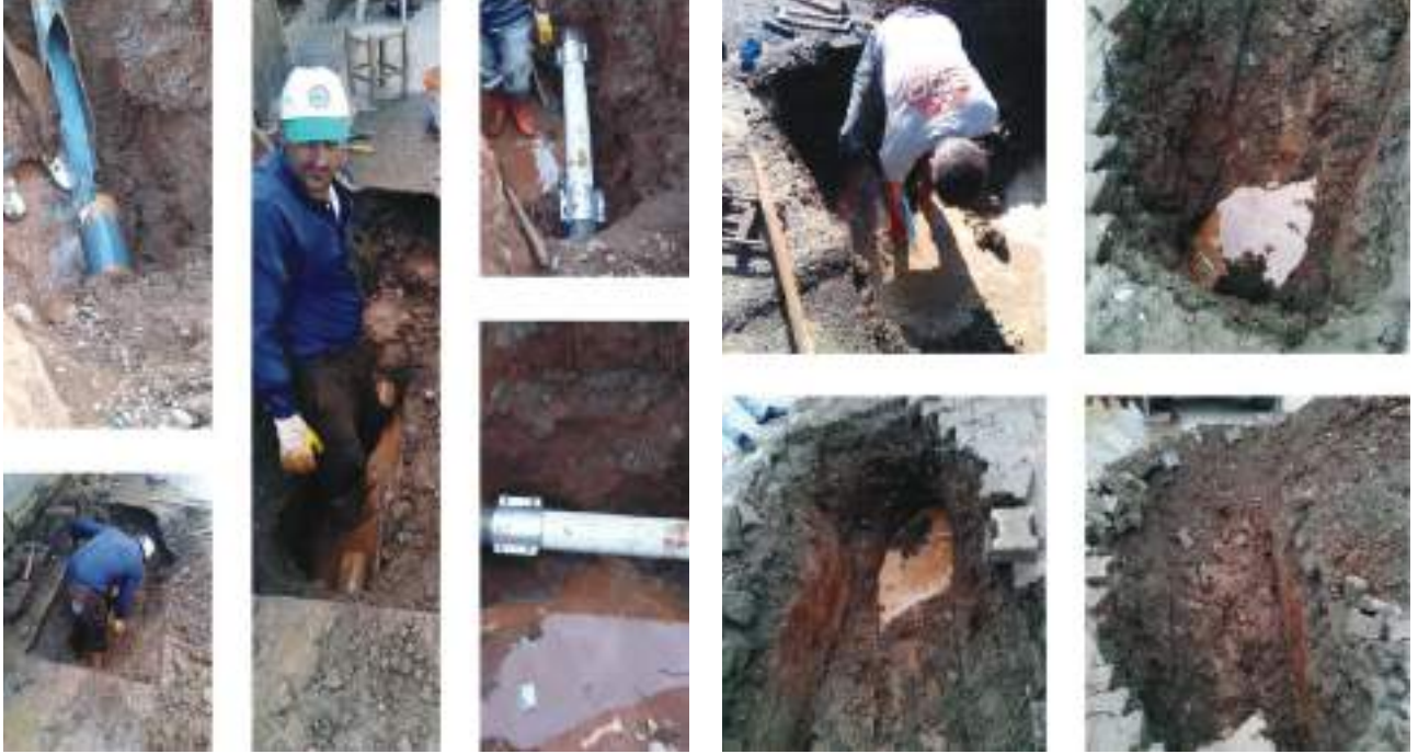
Muhtelif Cadde ve Sokaklarda Meydana Gelen İçmesuyu Arızaları Onarımı
