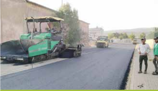
Karşıyaka Mah. Stad Sokak Asfalt Yol Yapım İşi
