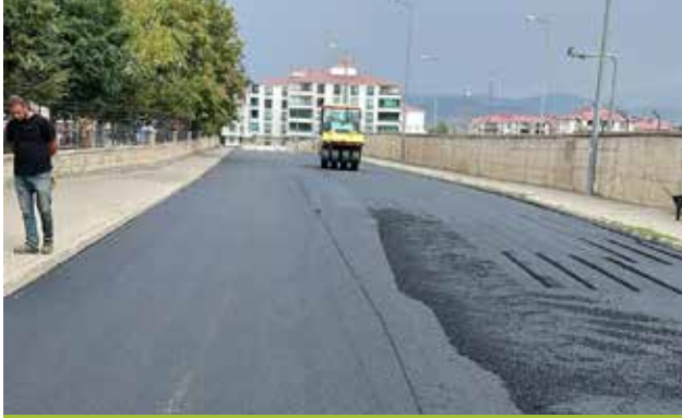
Kültür Mah. Şair Eşref Caddesi Yol Yapım İşi
