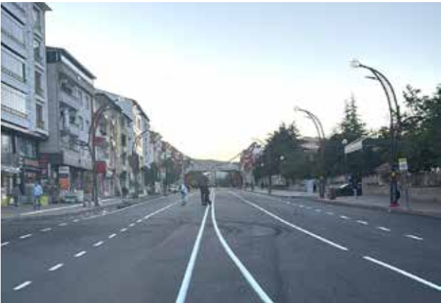
Kültür Caddesi BSK Asfalt Yol Yapım İşi
