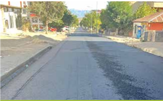
Yeşilyurt Mah. Yeşilyurt Caddesi Yol Yapım İşi
