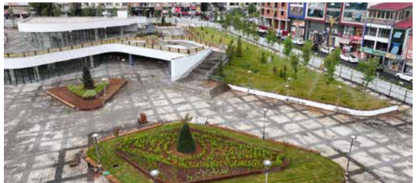
Kent Meydanı Yeraltı Otopark Yapım İşi Çalışmaları
