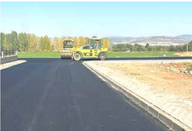
Kültür Mah. İstemihan Sokak BSK Asfalt Yol Yapım İşi
