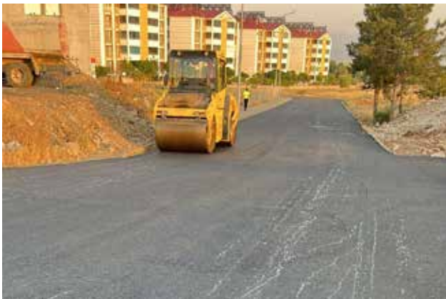
İnalı Mahallesi Gülhane Sokak Asfalt Yol Yapım İşi
