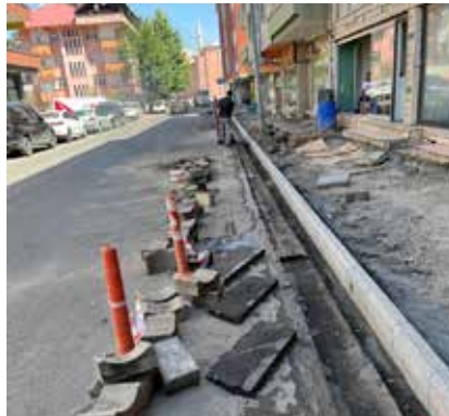
Yenisehir Mah.Cumhuriyet Cad. Bazalt Kaldırım Yapım İşi
