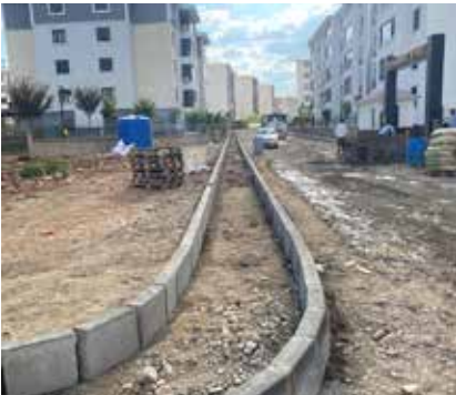
İstemihan Sokak Kaldırım Yapım İşi
