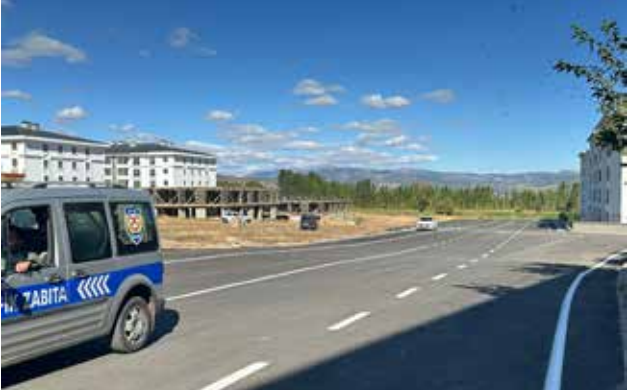
İnali Mah. İstemihan Sokak BSK Asfalt Yol Yapım İşi
