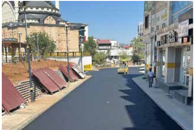
Yenişehir Mah. Evliya Çelebi Sokak BSK Yol Yapım İşi
