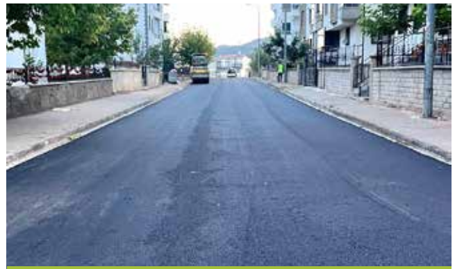
Saray Mah. Umud Sokak Yol Yapım İşi
