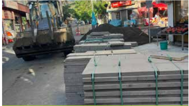
Hürriyet Caddesi Bazalt Kaldırım Yapım İşi
