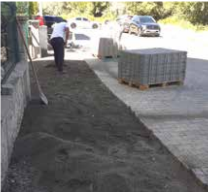
Kültür Mahallesi Karasu Cad. Yol ve Kaldırım Yapım İşi
