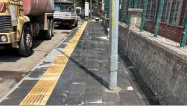
Cumhuriyet Caddesi Bazalt Kaldırım ve Engelli İz Yolu Yapım İşi
