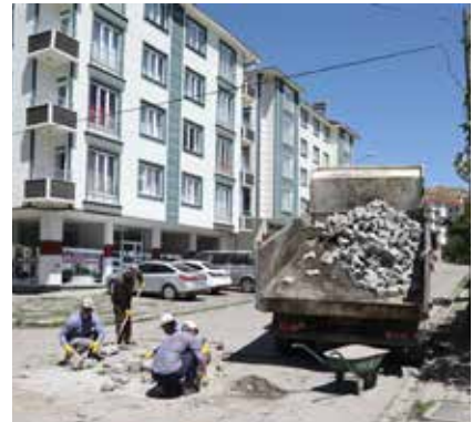
Belediyemiz yol ekipleri ile yapılan kilitli parke taşı onarım çalışması
