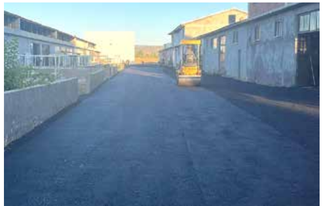
Simani Mah. Halıcılar Sitesi Asfalt Yol Yapım İşi
