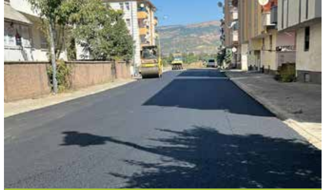
Kültür Mahallesi Emirhan Sokak Yol Yapım İşi
