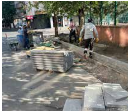
Cumhuriyet Caddesi Bazalt Kaldırım Yapım İşi
