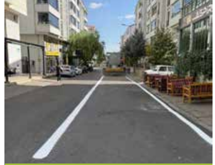
Ş. M. Gündoğdu Mah. Tunus Sokak Yol Çizgi Yapılması
