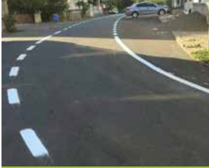
Ş. M. Gündoğdu Mah. Buhari Sokak Yol Yapım İşi
