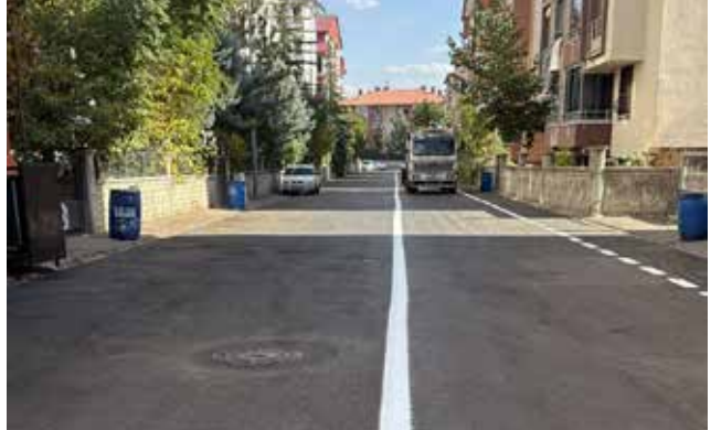
Ş.M.Gündoğdu Mah. Narin Sokak Asfalt Yol Yapımı
