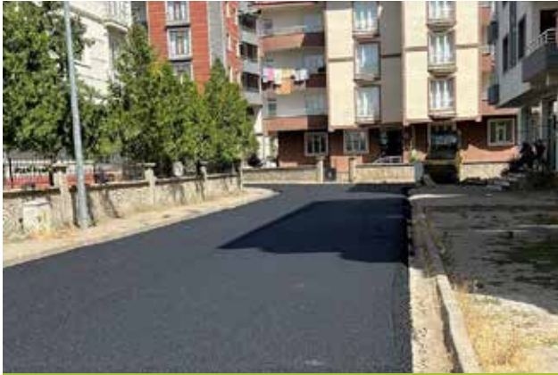
İnalı Mah. Menderes Sokak Asfalt Yol Yapım İşi
