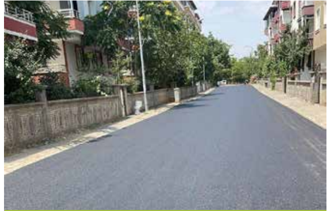
Ş.M.Gündoğdu Mah. Marmara Sokak Asfalt Yol Yapım İşi
