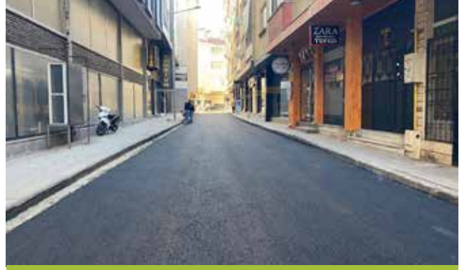
Yenişehir Mah. Sefa Sokak Yol Yapım İşi
